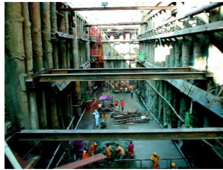
Vala com estacas hélice contínua e estacas hélice contínua atirantadas já escavada e estorcada na estação da Luz
