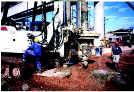
Hélice ômega preparada para iniciar a perfuração na estação Vila das Belezas
