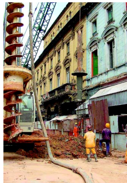
Pilão utilizado para execução de estacas hélice contínua na estação da Luz, próxima aos prédios da rua Mauá.
