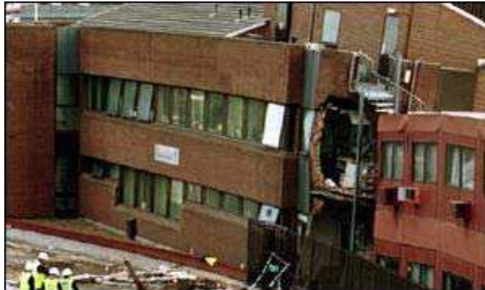
Figura 7 – Colapso de edificio subsiguiente al colapso de los túneles de Heathrow (1994)
