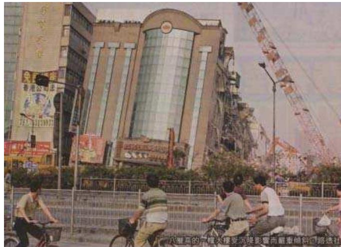
Figura 12 – Otro colapso en el Metro de Shangai, China, 2003
