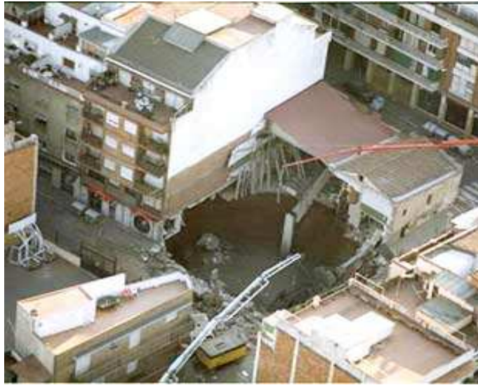
Figura 5 – Colapso en túnel en construcción en Suiza
