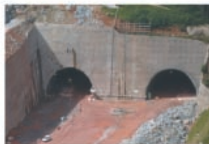
Túnel 1 - Emboque Gramado.
