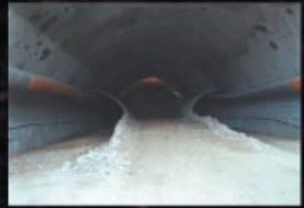
Túnel 2 - Escavação em side-drifts.
