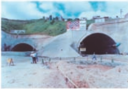
Túnel 2 - Emboque Imperial.
