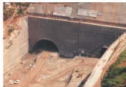
Túnel 1 - Emboque Vista Alegre.
