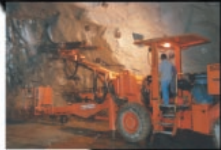
Túnel 3 - Perfuração.
