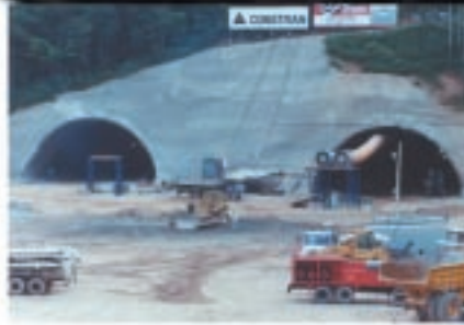
Túnel 3 - Emboque Itahyê.
