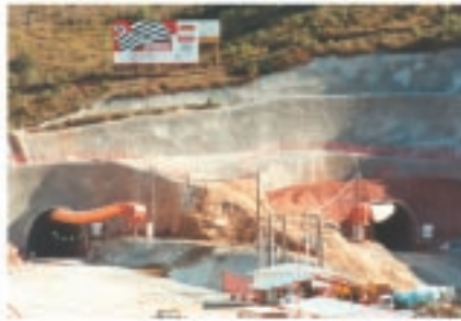
Túnel 3 - Emboque Jesus.
