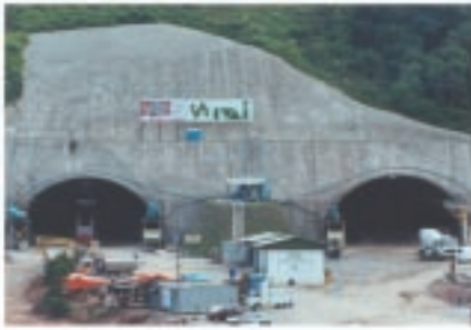
Túnel 2 - Emboque Tamboré.
