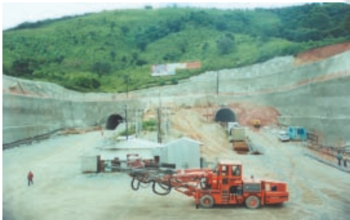
Túnel 3 - Emboque Jesus.
