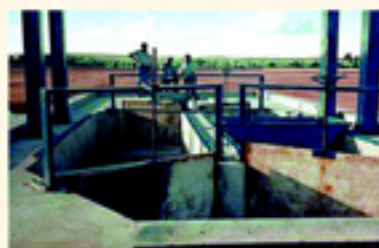
Estação de Tratamento de Esgotos da CAGECE/Fortaleza
