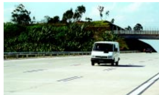
Deslocamento entre as rodovias que interceptam o Trecho Oeste está facilitado
