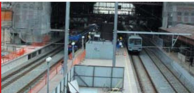
**A superestrutura das vias férreas do lado norte foram desmontadas, as interferências removidas e em seguida iniciada a execução de estacas-raiz de reforço de blocos de fundação existentes e de contenção de vala. Para o fechamento do perímetro de vala foram cravados perfis metálicos provisórios paralelamente à plataforma central**
