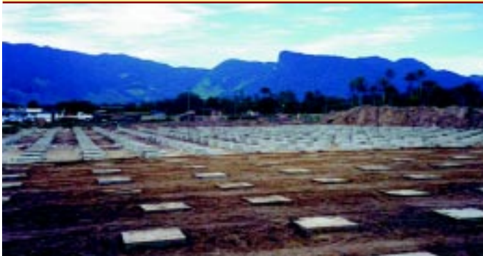
Vista dos capitéis sobre estacas de concreto pré-moldadas, com o reaterro em execução
