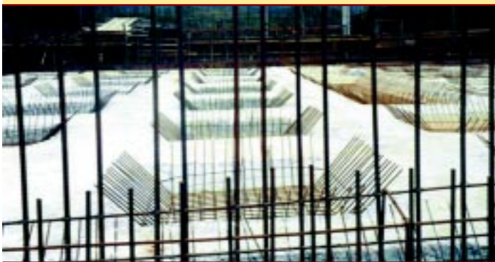
Detalhe da concretagem da laje de fundo, com o concreto magro já colocado, e a armação do engrossamento do radier sobre capitéis
