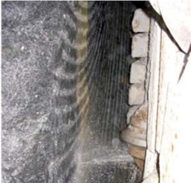
Redução de temperatura da frente de escavação com água.
