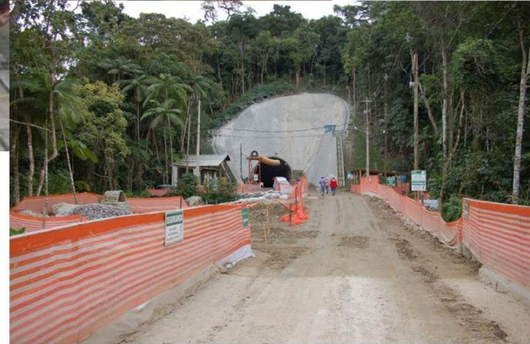
Tuneladora em rocha para túnel sob a Serra do Mar
