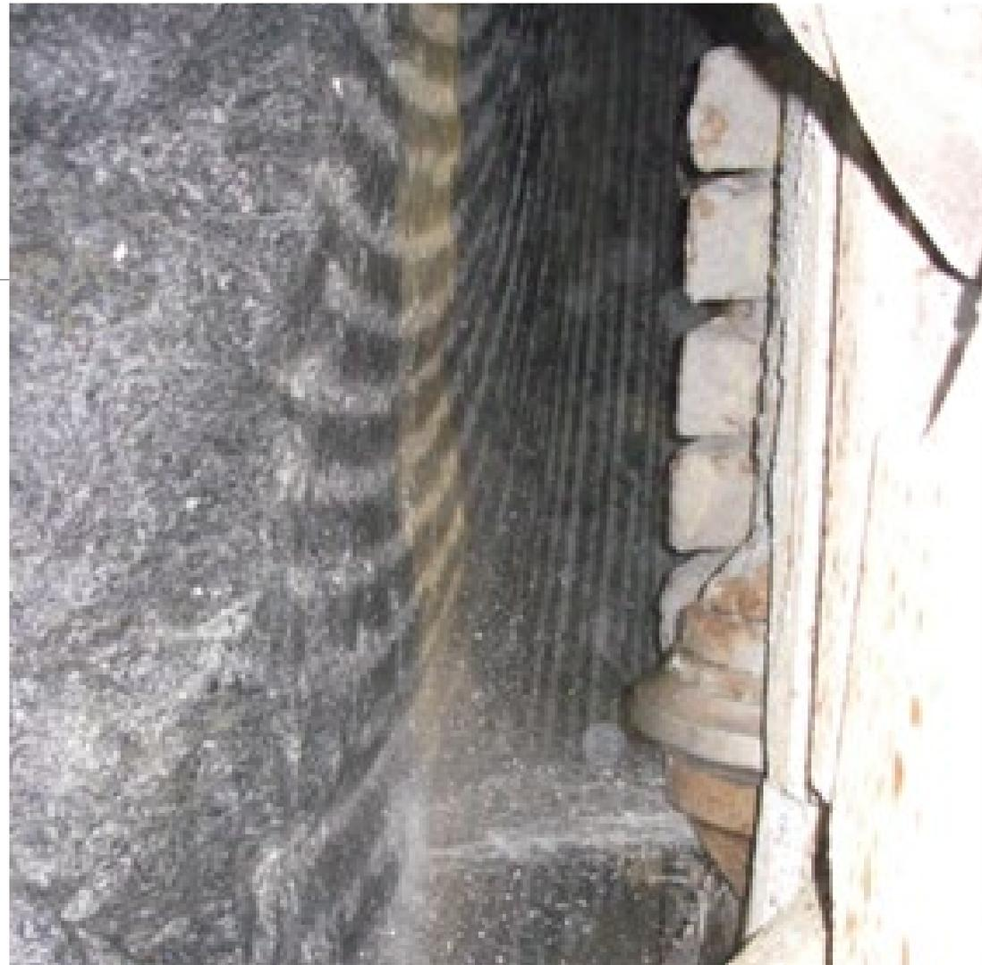
Redução de temperatura da frente de escavação com água
