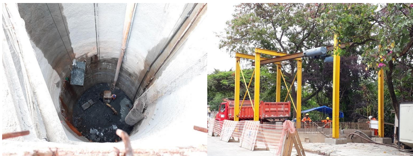
Figura 8: (a) Retirada do material de escavação através de caçambas (b) vista da ponte rolante a partir da superfície. (Fonte: ATO GeoCompany)
