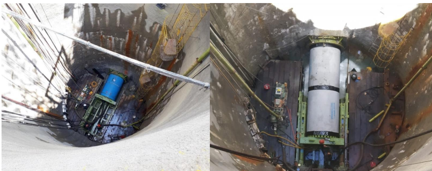
Figura 4: Vista superior do poço de partida (a) emboque do shield pela parede de poço e (b) cravação dos anéis de concreto. (Fonte: ATO GeoCompany)
