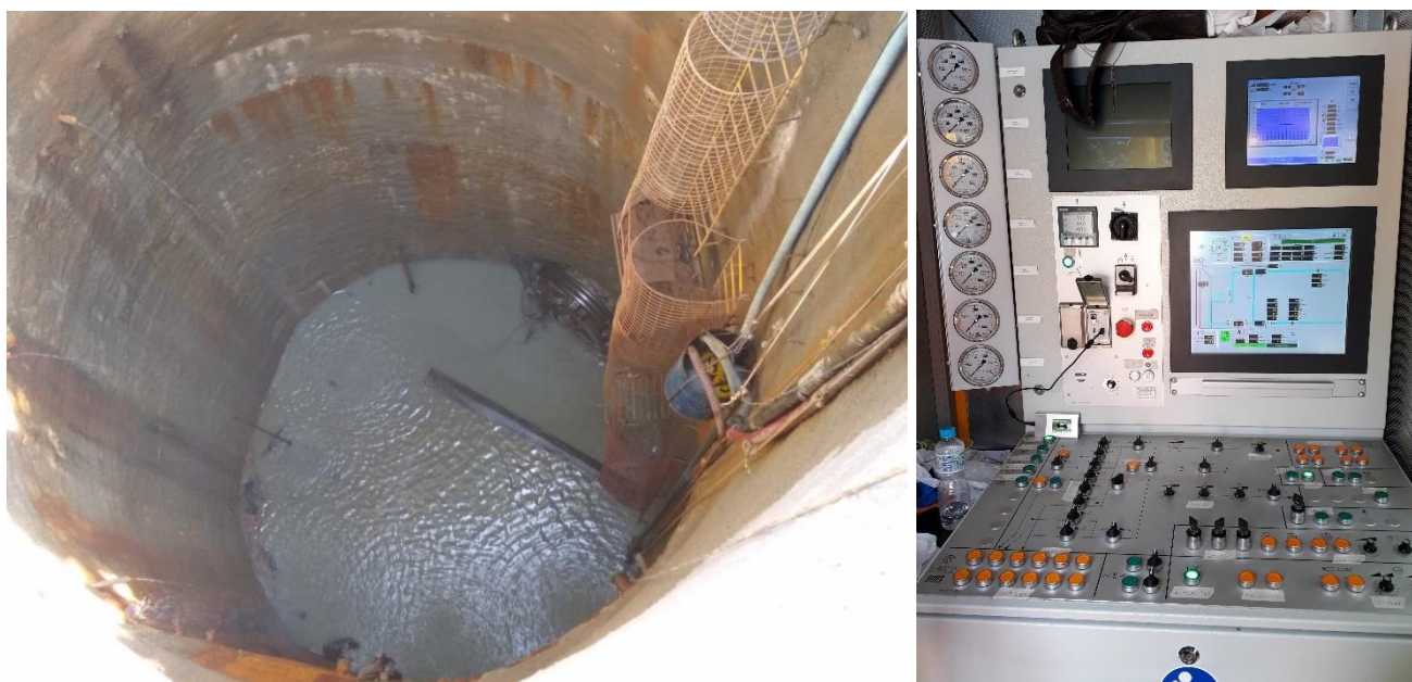
Figura 5: (a) Vista do desemboque do shield , sendo possível observar que o equipamento ultrapassou as telas metálicas utilizadas no revestimento do poço. Foi utilizada água no interior do poço para balancear a pressão na chegada do equipamento e (b) cabine de controle do equipamento. (Fonte: ATO GeoCompany)
