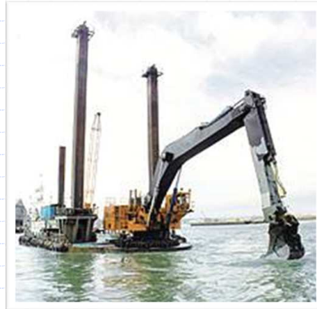
Figura 2 – Abertura da trincheira. www.geocompany.com.br
