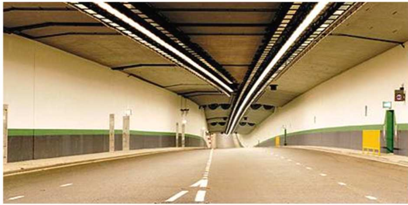
Figura 12 – Aspecto final do túnel acabado.
