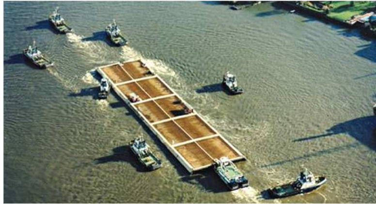
Figura 6 – Transporte do elemento até o local de instalação.
