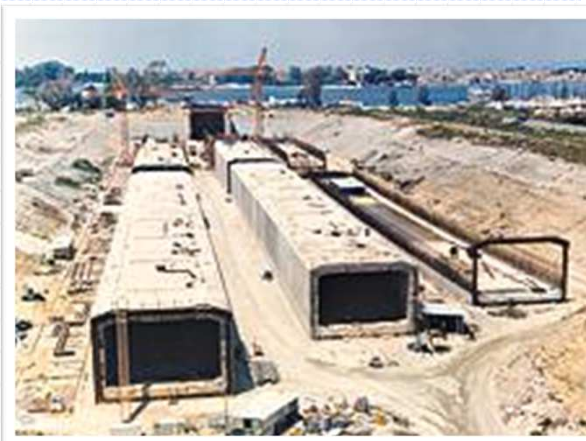
Figura 3 – Fabricação dos elementos em uma doca seca. www.geocompany.com.br
