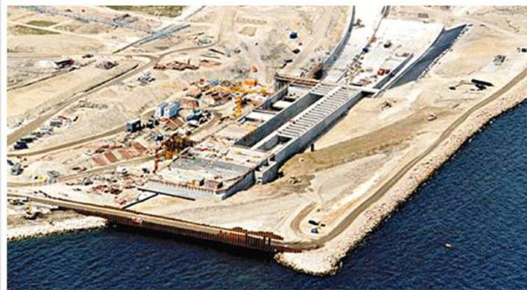
Figura 11 – Execução da estrutura de aproximação a seco.
