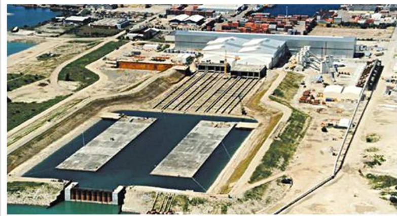
Figura 5 – Fase de Inundação da doca seca.
