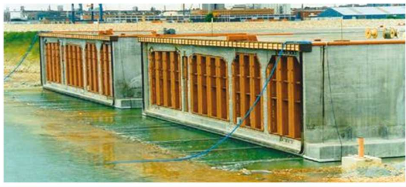
Figura 4 – Vedação temporária dos elementos.
