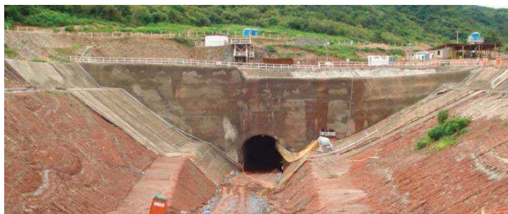
Diferença de inclinações entre os taludes esquerdo e direito (menos acentuado).
