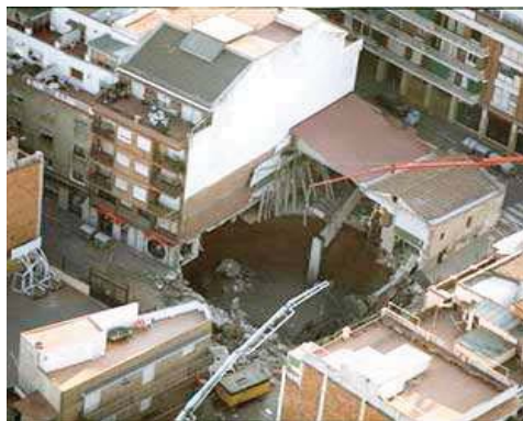
Colapso de túnel em construção na Suíça
