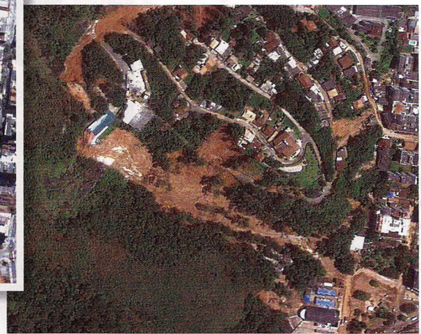
Imagem posterior às chuvas (20/01/2011) mostrando os danos causados
