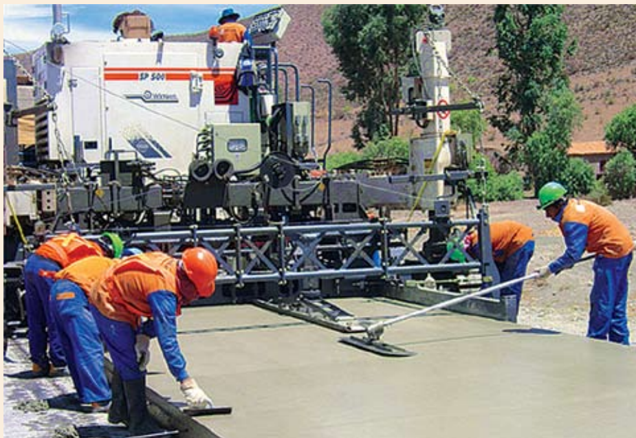
Execução de pavimento rígido em obra rodoviária, Bolívia
