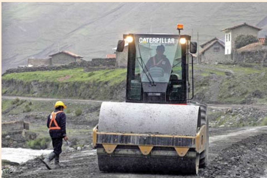
Obras da Rodovia Interoceânica, Peru
