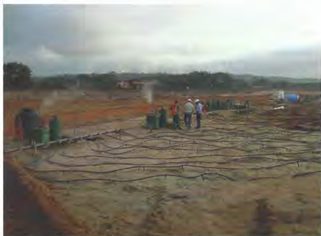
Início do adensamento rápido com drenos a vácuo no México, em uma obra que o engenheiro trabalhou
