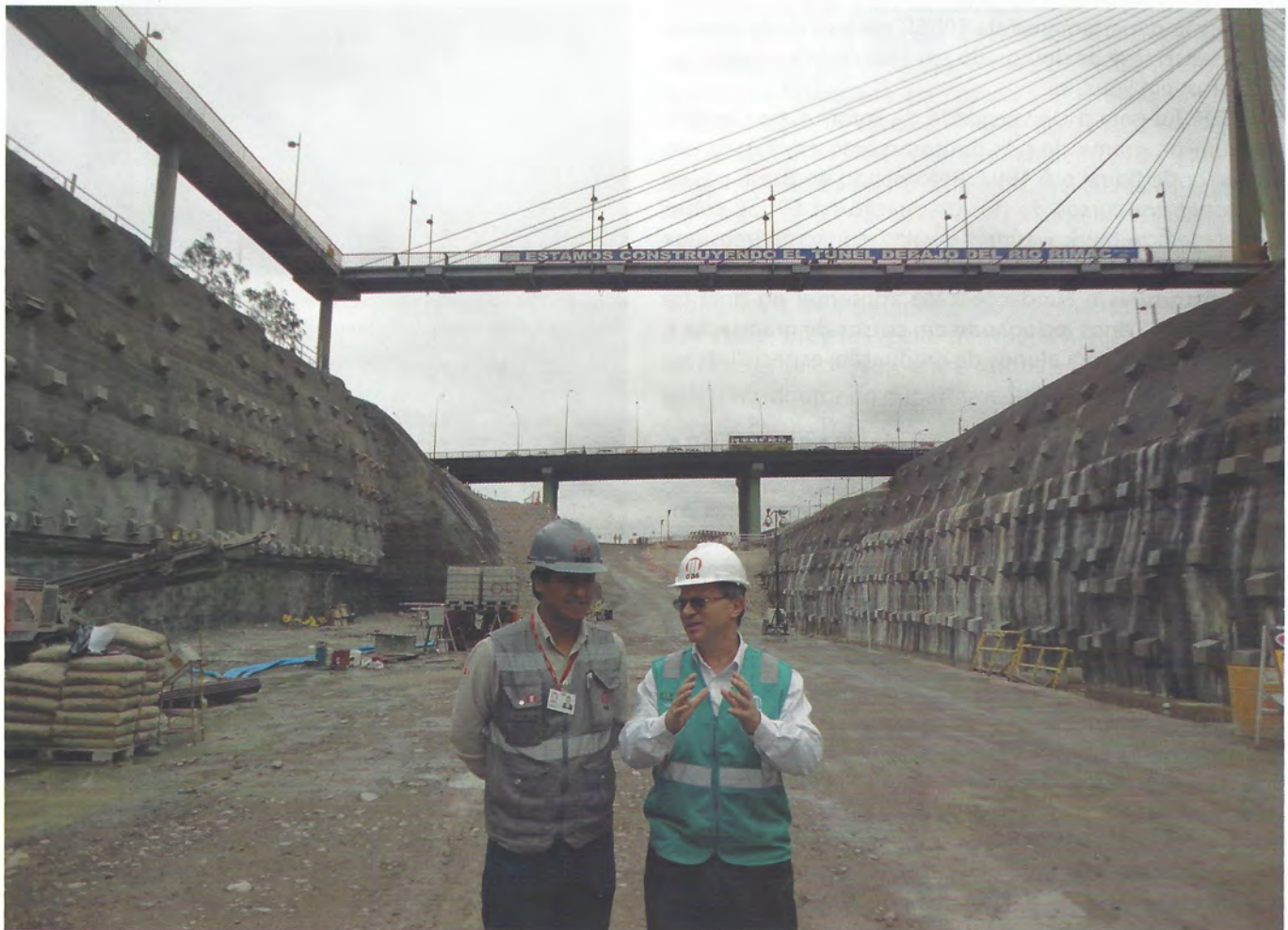
Kochen nas obras do túnel sob o Rio Rimac, no Peru, com um engenheiro peruano
