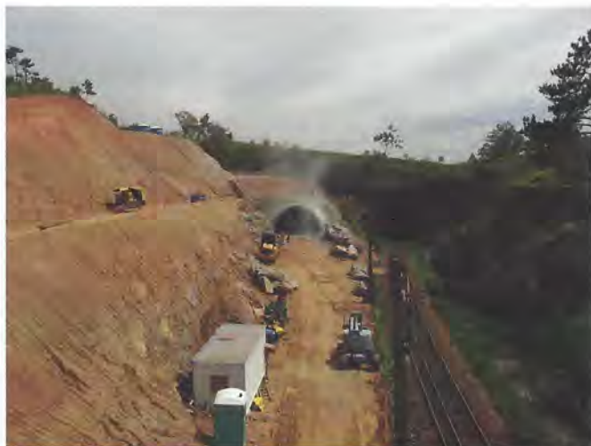
Duplicação de túnel da ferrovia ALL (América Latina Logística), sob a Rodovia Castelo Branco, em São Paulo, um dos projetos em que Kochen atuou
