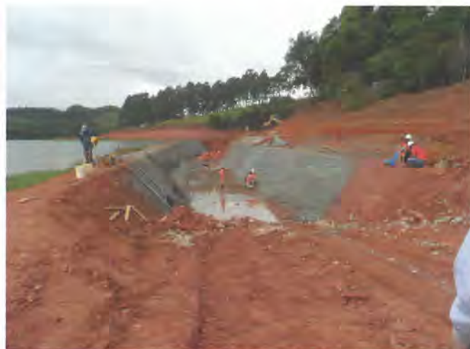
Obras para bombeamento do volume morto da represa Atibainha, em São Paulo
