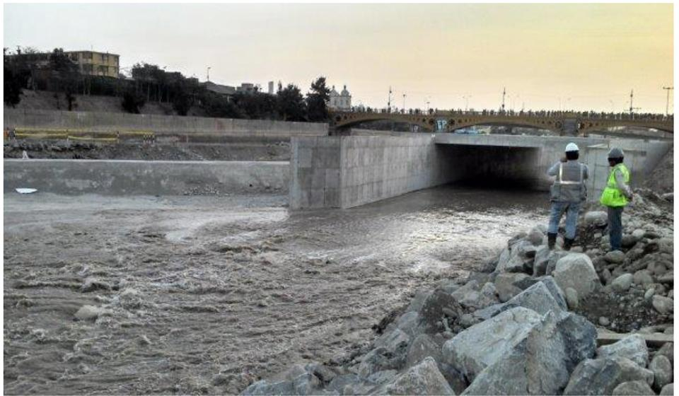
Figura 9: Operação do segundo dique, desviando a água do rio para o canal provisório. Este dique viabiliza verter o excedente de água do rio na época de cheia para seu leito natural, evitando o alagamento das vias lindeiras.
