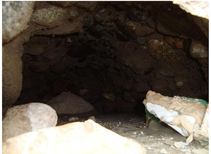
Figura 12: Nível de degradação do maciço inicialmente observado durante a execução dos chumbadores, com risco de recalques do terreno.
