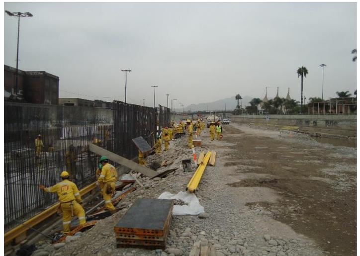
Figura 6: Execução do canal provisório, em concreto armado moldado In Loco.
