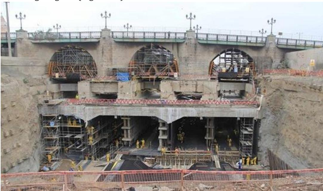
Figura 20 - Execução do túnel sob ponte histórica de pedra
