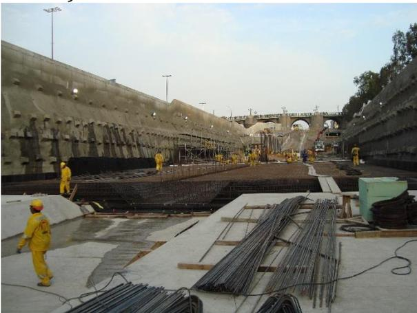
Figura 15: Execução do concreto armado da laje de fundo, moldados In Loco.
