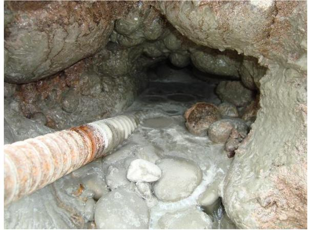
Figura 11: Dificuldade na execução das perfurações para os chumbadores. Erosão e desvio da haste.
