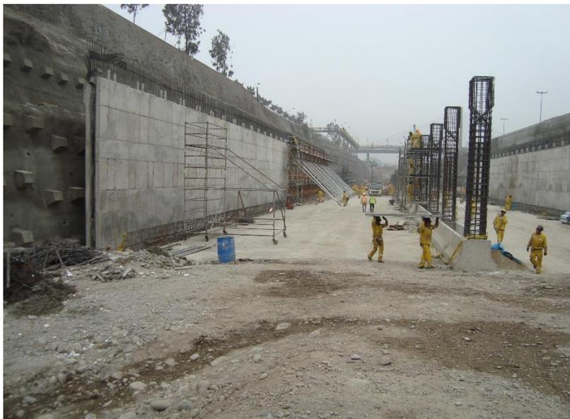
Figura 4: Módulo típico do túnel em execução, observando laje e paredes em concreto armado moldado In Loco, para reduzir juntas e evitar risco hidráulico de perda de finos e potencial solapamento.
