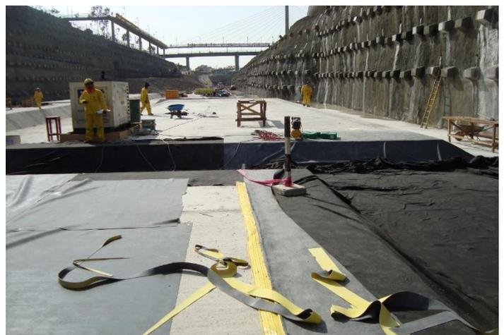
Figura 17: Execução do sistema de impermeabilização.
