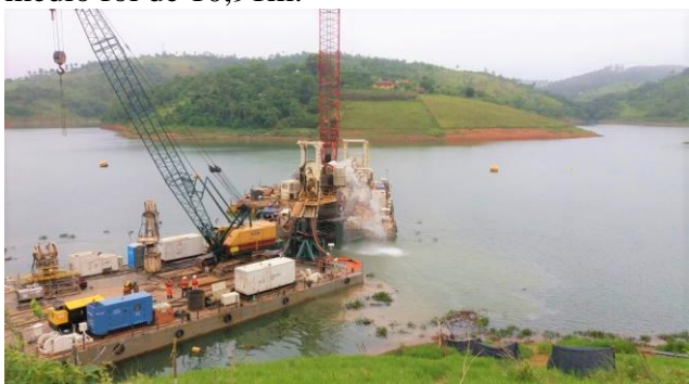
Figura 5 – Escavação da base da fundação com diâmetro de 4,20m
