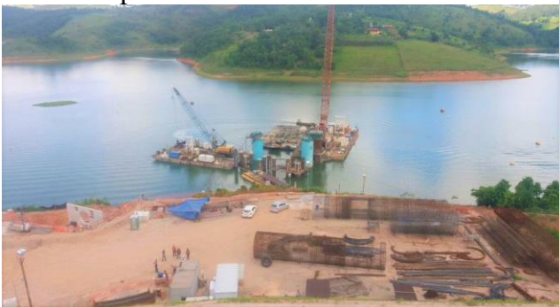
Figura 3 – Construção através do apoio de flutuantes e guindastes
