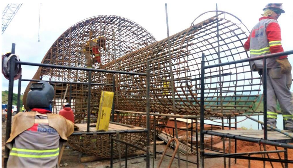
Figura 7 – Estrutura de armação em forma de cálice para o pino e base da fundação
