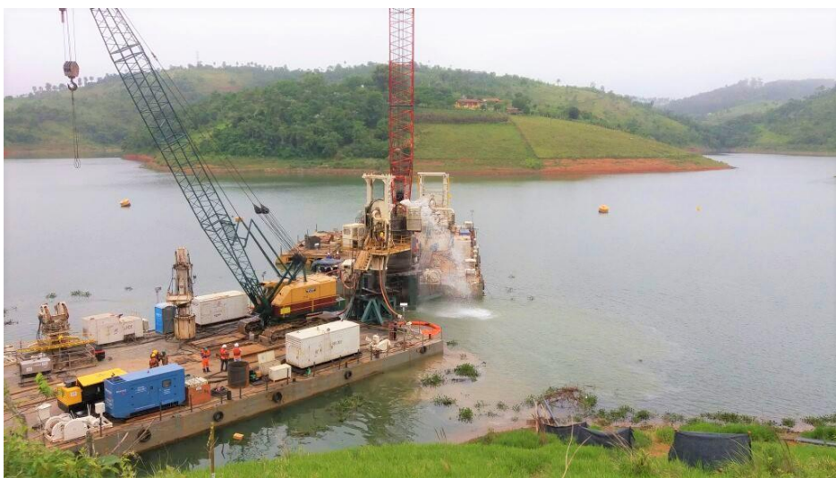
Figura 6 – Escavação da base da fundação com diâmetro de 4,20m.
