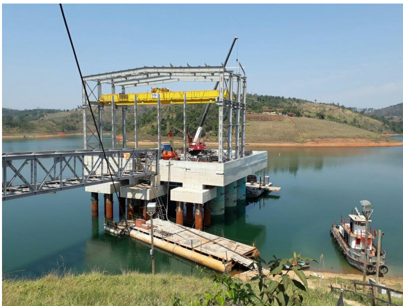
Figura 1 – EEAB Jaguarí – vista durante a execução
