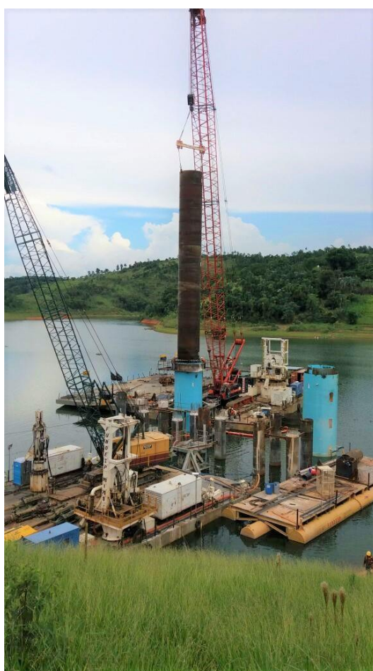
Figura 8 – Instalação da camisa metálica do poço de captação
