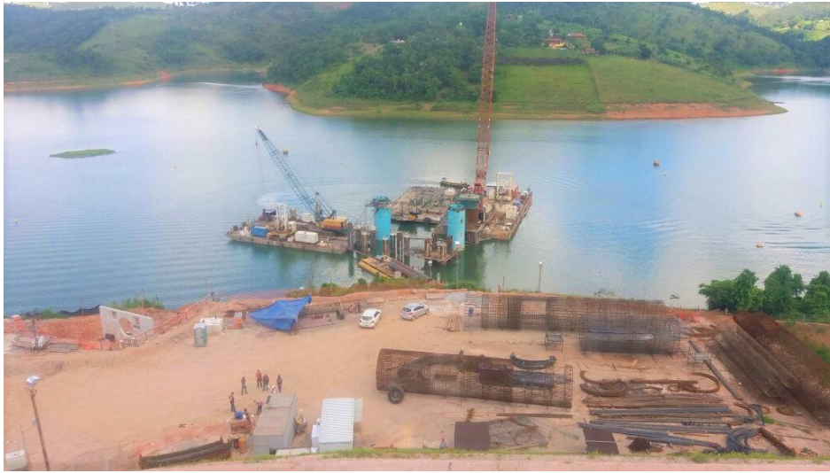
Figura 3 – Construção através do apoio de balsas e guindastes
