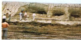
VISTA DEL TALUD DE AGUAS ABAJO; OBSERVESE QUE AFUERA DEL PIE DEL TALUD Y LOS TUNELER ATRAVIESAN DE UN LADO A OTRO
