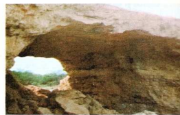
TUNEL VISTO DE AGUAS ARRIBA HACIA AGUAS ABAJO; SE OBSERVAN LAS CAPAS COMPACTADAS
