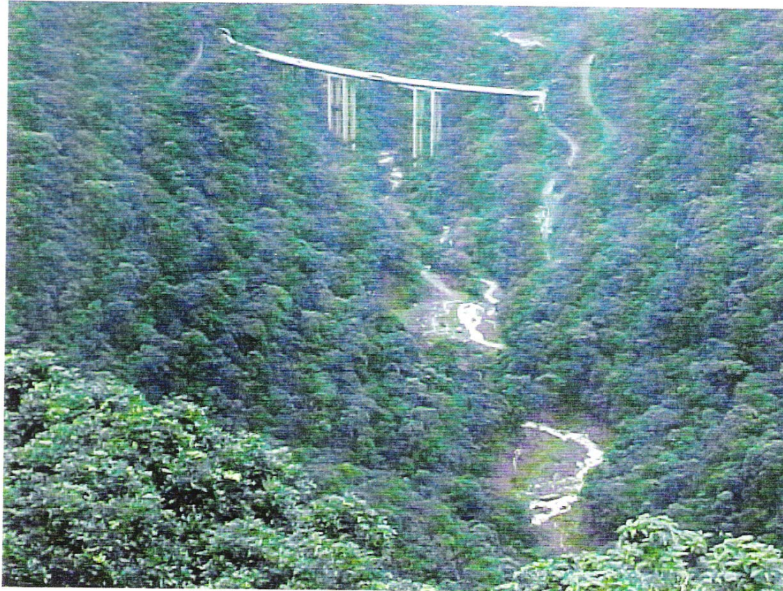
Vista do talvegue a jusante.
