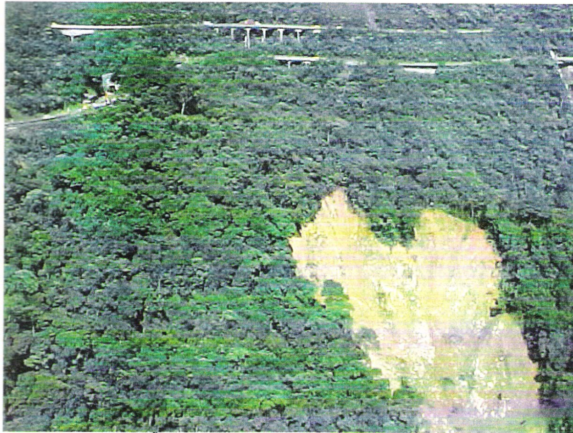
Escorregamento junto com a pista sul.
