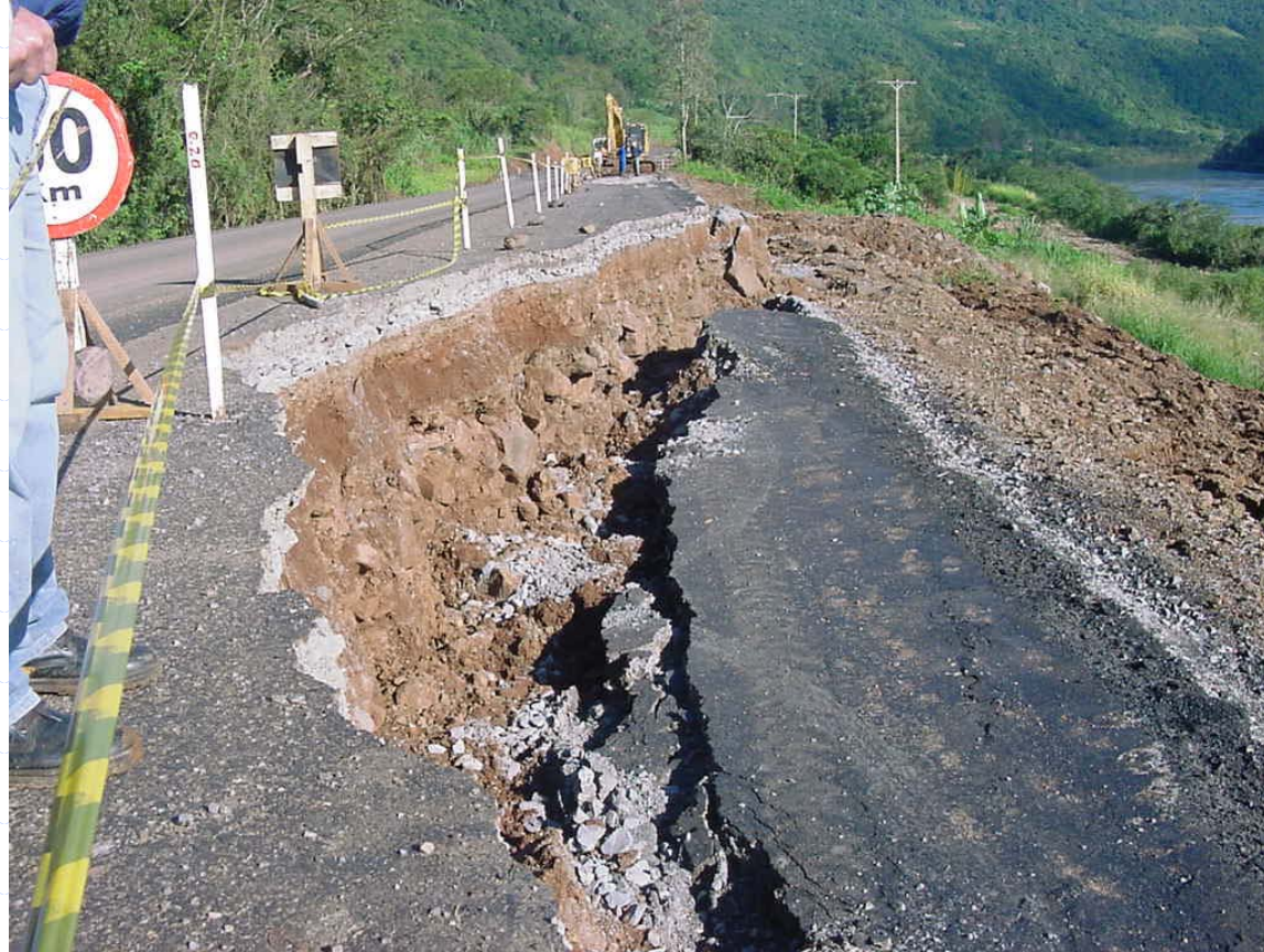
Ruptura do corpo estradal, evolução.
