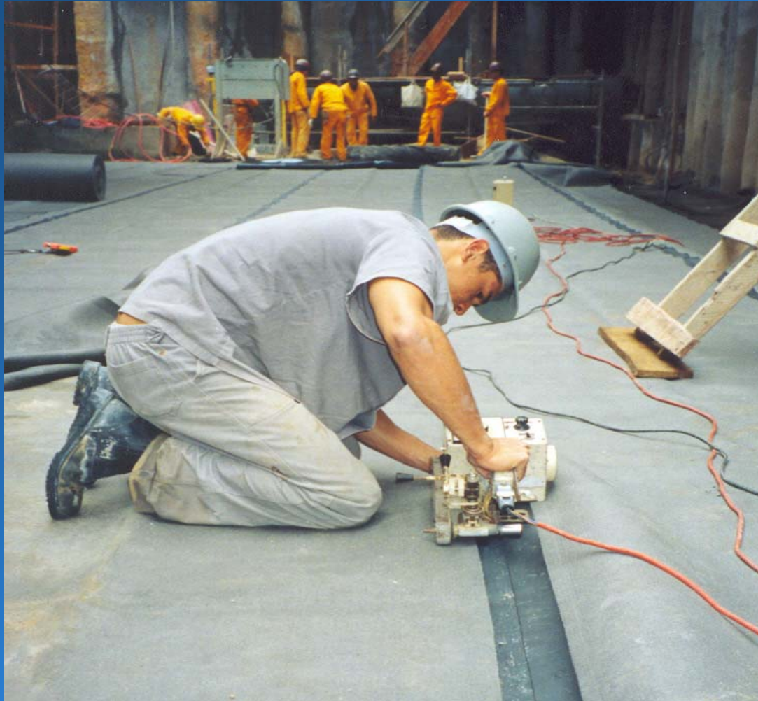
Figura 4 – Soldagem por termofusão no Geocomposto. (Geomembrana de PVC acoplado ao Geotêxtil)
