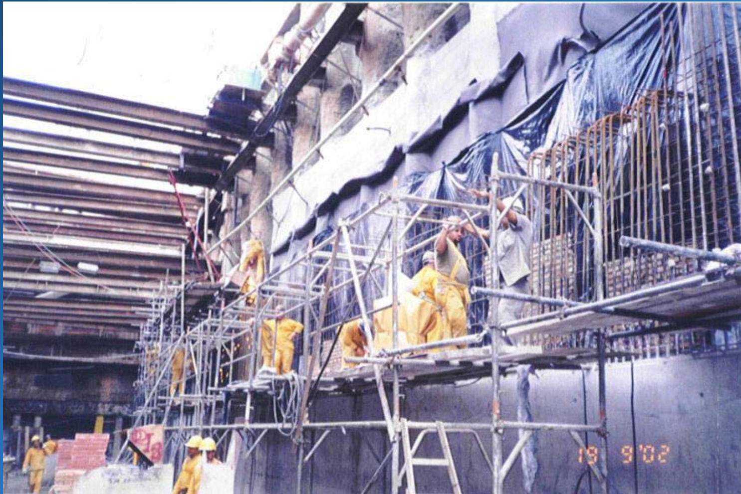
Figura 6 – Vista geral da parede da vala da Rua Mauá, com o geocomposto fixado, e com o filme de polietileno de proteção (Set/2002).
