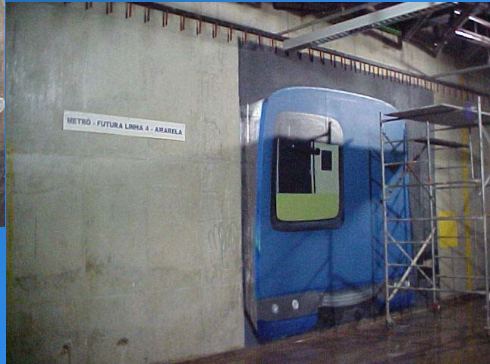
Figura 11 – Comparação entre a situação das infiltrações, antes e depois do tratamento com injeções químicas (Set/2004).
