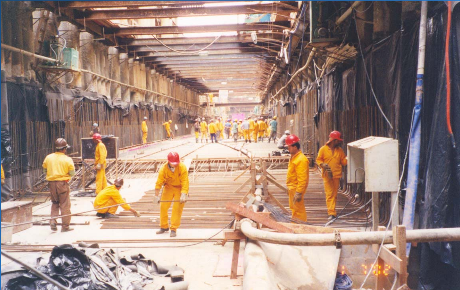
Figura 3 – Vista do túnel com piso concretado sobre Geocomposto e lateral com concretagem parcial.
