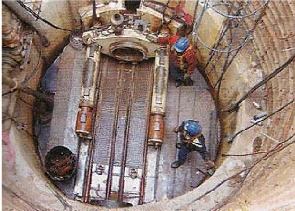
Foto 9 - Exemplo de Poço de Cravação em Operação
