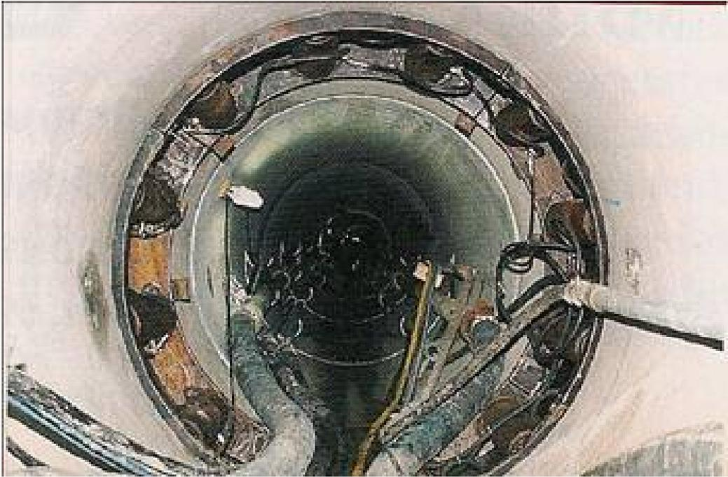
Foto 11 - Vista de Estação Intermediária de Cravação para Pipe Jacking de Grande Extensão
