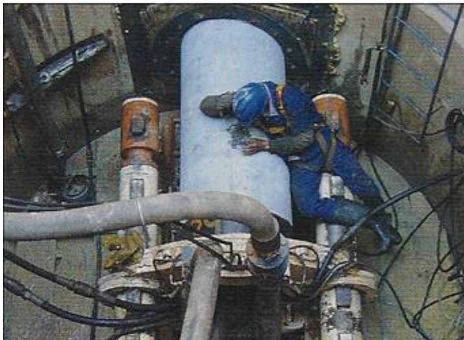
Foto 4 - Início da Cravação de Tubo Pré Fabricado
