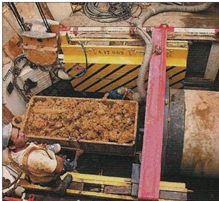
Foto 14 - Material Escavado sendo removido por vagoneta
