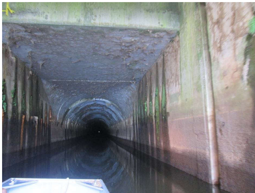
Figura 4 – Vista do emboque do túnel de transferência Jundiá – Taiapuêba.
