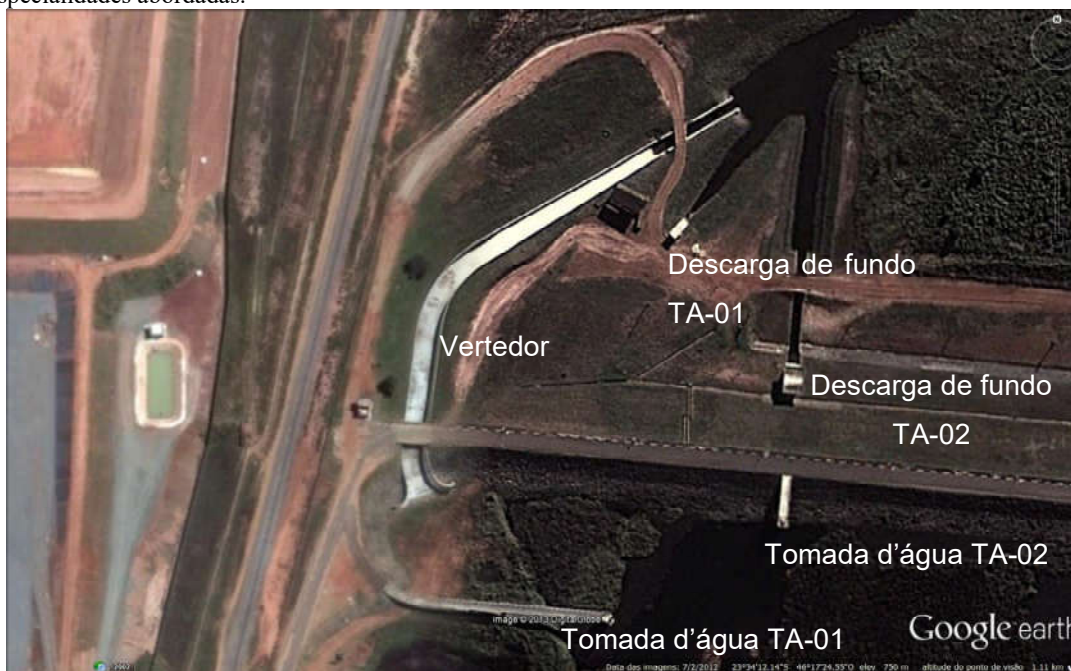
Figura 6 – Estruturas inspecionadas na Barragem de Taiacupeba.
