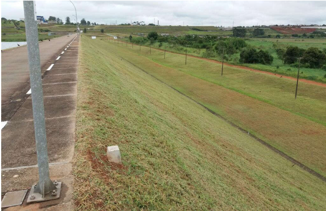
Figura 9 - Área de jusante da Barragem Taiaçupeba após a conservação de áreas verdes.
