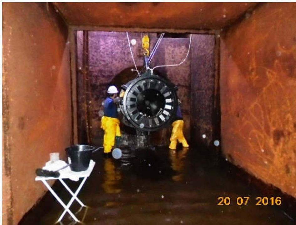
Figura 11- Instalação de Válvulas Dispersoras na Barragem Ponte Nova
