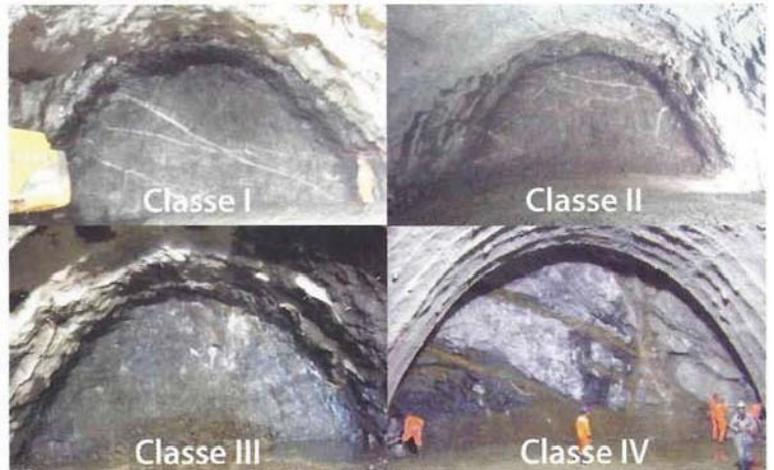
Figura 2 – Classificação do maciço (BARTON *et al*, 1974), durante a execução das escavações do túnel do EBN.
