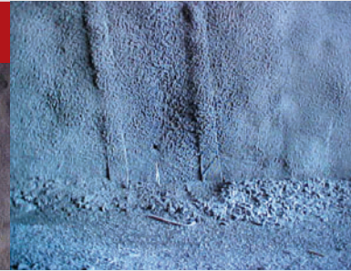
Geodrenos em forma de leque na interface revestimento primário – revestimento secundário
