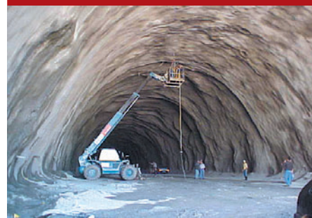
Túnel sendo preparado para instalação do revestimento secundário
