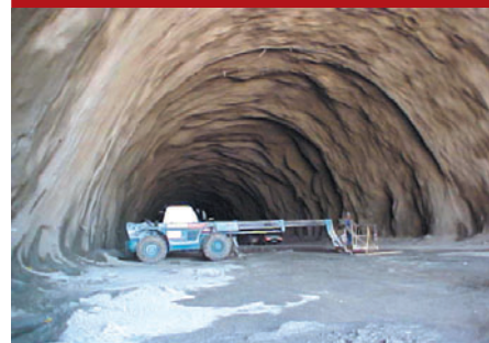
Vista do túnel antes da instalação do revestimento secundário
