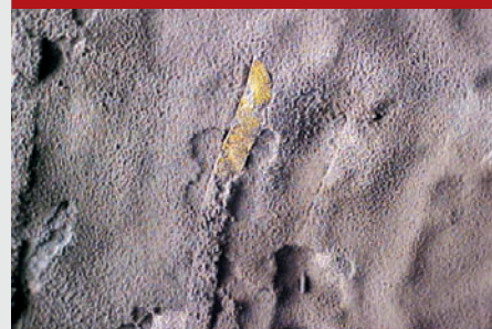
Geodreno sendo embutido na interface revestimento primário – revestimento secundário
