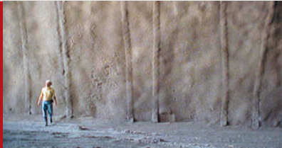
Geodrenos sendo instalados na interface revestimento primário – revestimento secundário
