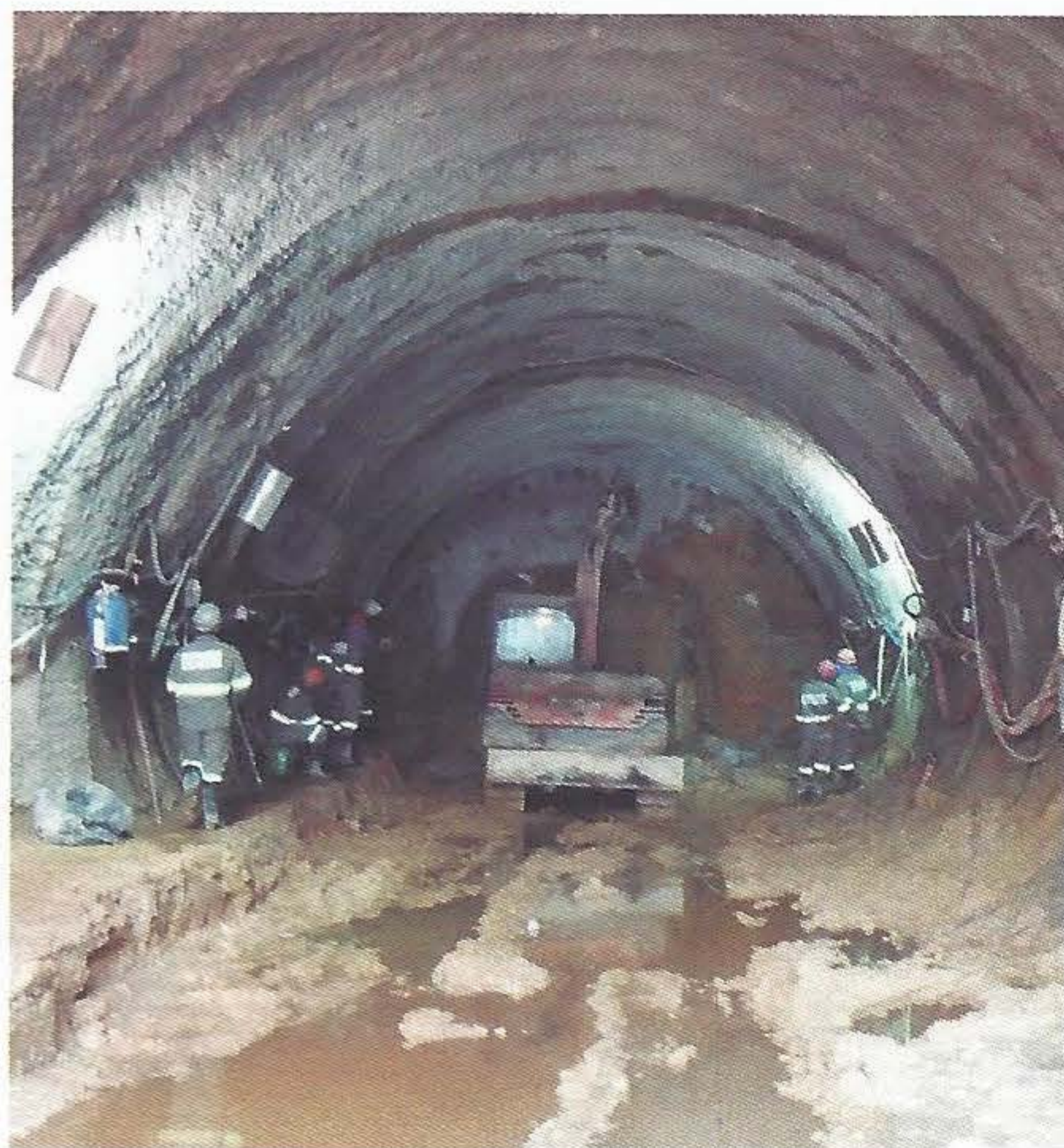
Infraestrutura de túnel para sistema viário
