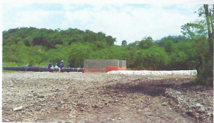
Foto 7 - Vista Geral do Ponto de Lançamento (durante a construção)
