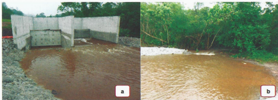
Foto 8 - Operação de teste de uma linha adutora - Fase Construtiva: (a) Vista de Montante; (b) Vista de Jusante com lançamento no córrego Taiaçupeba-Mirim
