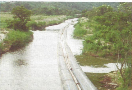
Foto 4 - Tubulação desfilada em trecho aquático
