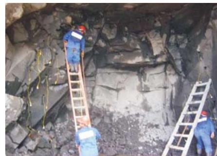
Figura 3 - Exemplos de junta-falha em talude de escavação e fraturas sigmóides em túnel
