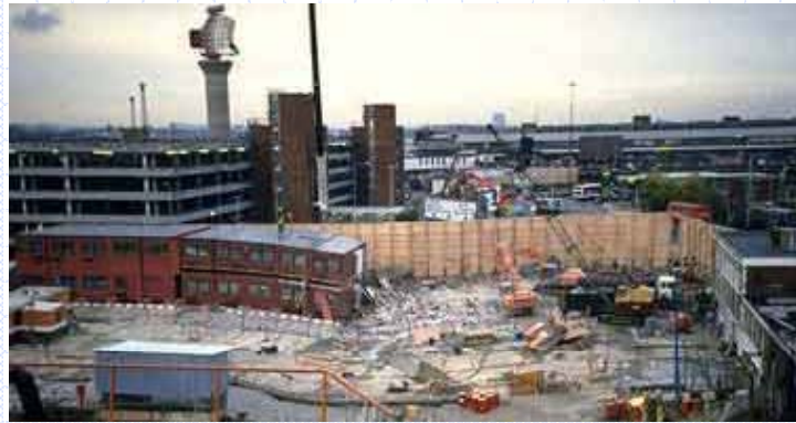
Vista Geral da Área Afetada pelo Colapso (Heathrow, 1994), após demolição de edificações arruinadas
