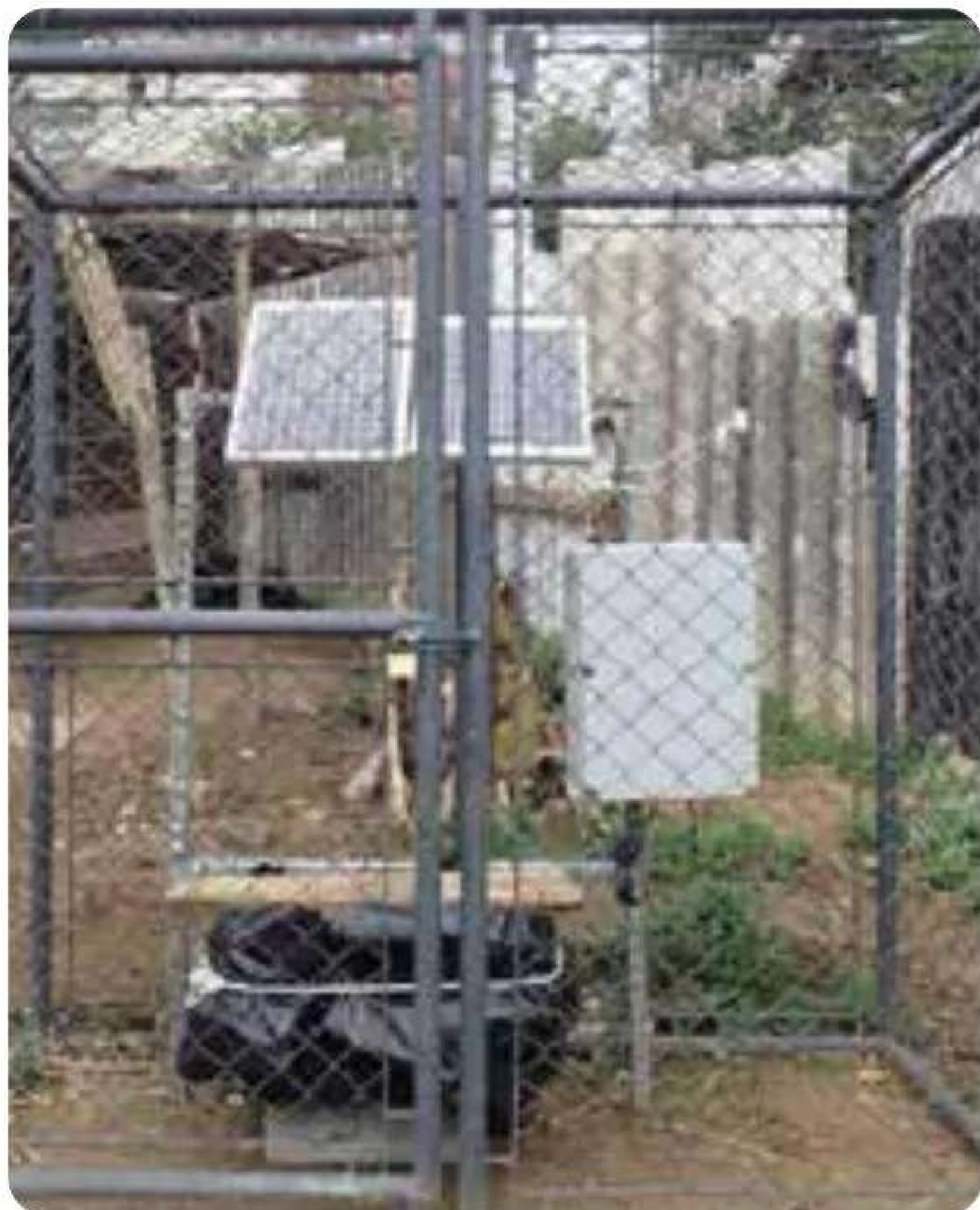
Gaiolas antivandalismo foram instaladas para evitar danos às estações de monitoramento de solo em área de risco de desastre natural em Barueri, município da região metropolitana de São Paulo
