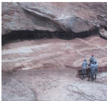
Barragem de Camará – Falha na Ombreira Esquerda
