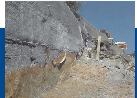
Trecho de contenção com concreto projetado, barbacãs, drenos perimetrais e grampos já executados
