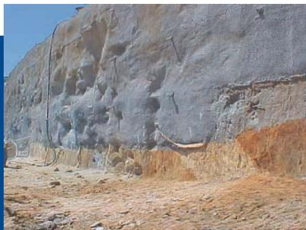
Face do corte revestida em concreto projetado
