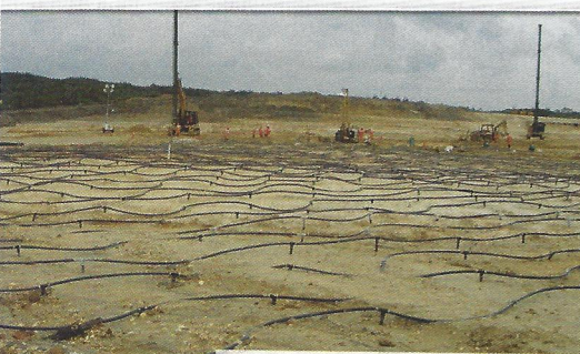
Melhoramento de solos com drenos a vácuo
