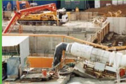
Foto 13 - Aeroporto de Heathrow - ruptura do túnel, pela superfície, junto ao poço de emboque
