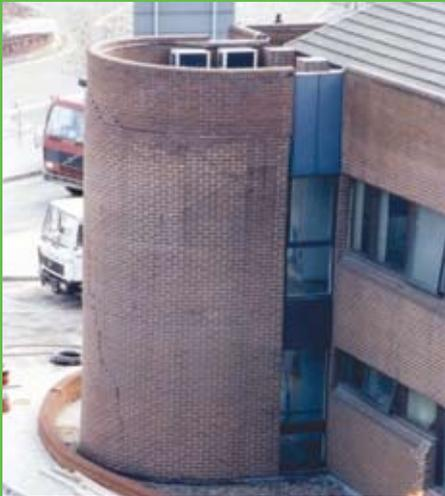
Foto 12 - Aeroporto de Heathrow (Ligação Expressa Heathrow - Paddington, 1994) - início do processo de ruína da edificação, com ocorrência de trincas e fissuras severas na mesma
