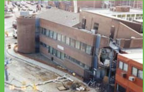
Foto 14 - Aeroporto de Heathrow - ruína total do prédio sobrejacente aos túneis da estação final da Ligação Expressa Heathrow - Paddington
