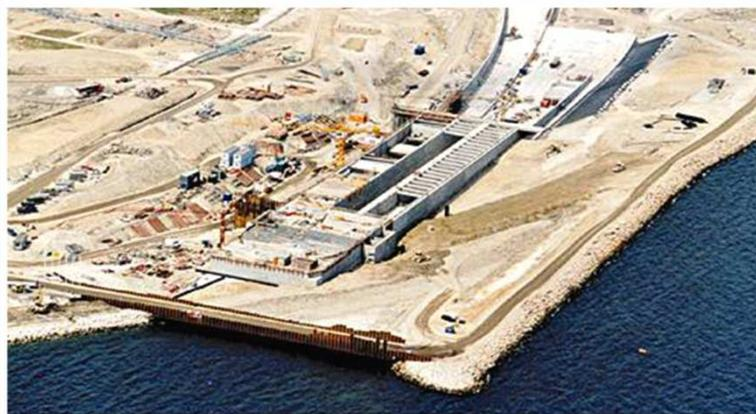
Figura 11 – Execução da estrutura de aproximação a seco.
