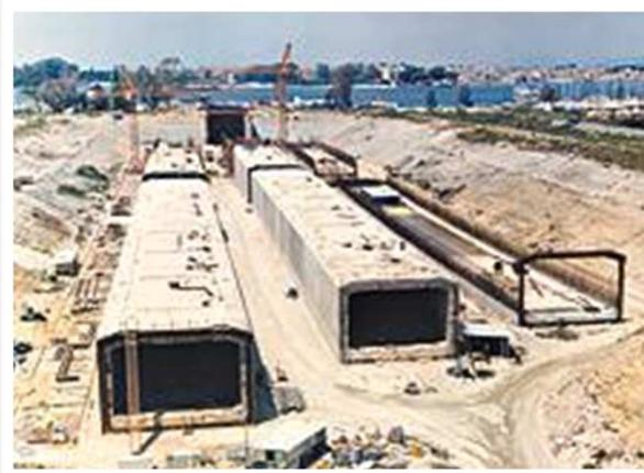
Figura 3 – Fabricação dos elementos em uma doca seca.
