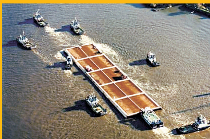
Transporte do elemento até o local de instalação (Tribune, 1999)
