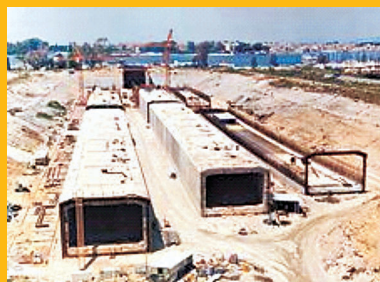
Fabricação dos elementos em uma doca seca (Tribune, 1999)
