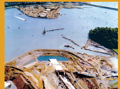
Vista geral do canteiro de obras (Tribune, 1999)
