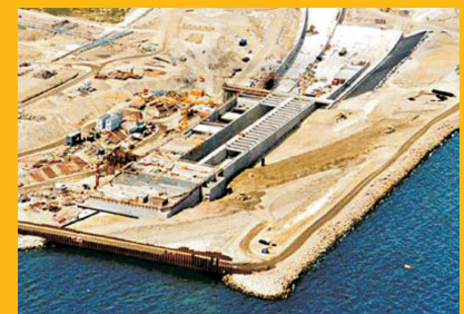
Execução da estrutura de aproximação a seco (Tribune, 1999)
