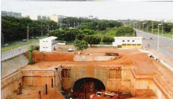
Foto 8 – Vista de Estação na Asa Sul, com emboque do túnel já escavado, Metrô DF (CBT, 2006)
