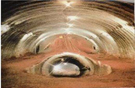
Foto 2 – Vista do túnel de acesso à calota superior da Estação Brigadeiro durante a construção (CBT, 2006).
