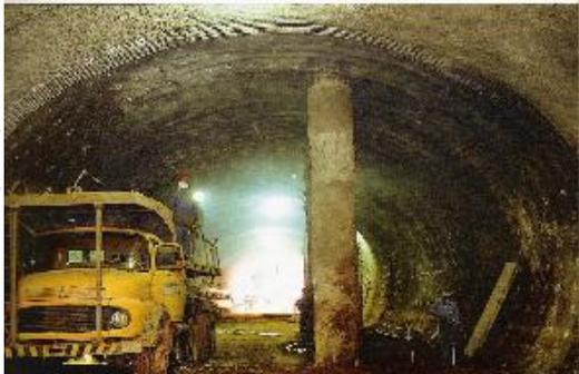
Foto 10 – Passagem do Túnel de Via do Metrô DF sob estrutura com fundação profunda (CBT, 2006)
