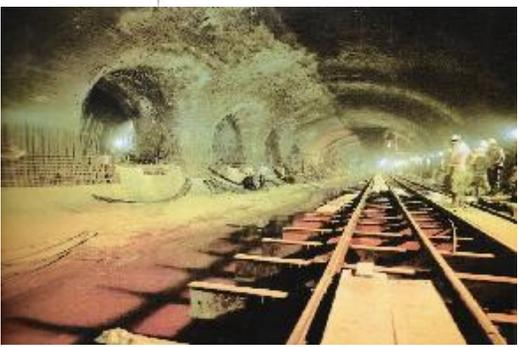
Foto 3 – Vista do Interior da Estação Consolação durante a escavação (CBT, 2006)
