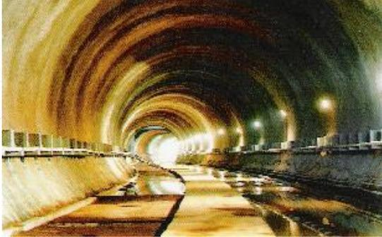
Foto 9 – Túnel Via Dupla com Revestimento Secundário já acabado (CBT, 2006)
