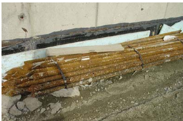
Figura 10a: Tubos de Congelamento Horizontais no Metro de Boston - Boston, MA, 2004
