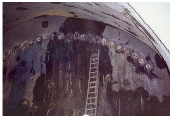
Figura 10a: Tubos de Congelamento Horizontais no Metro de Boston - Boston, MA, 2004
