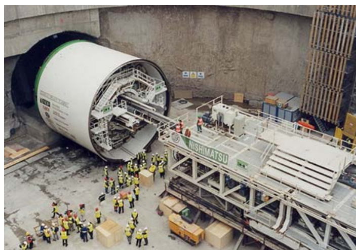
Figura 1a: TM – Início de Escavação na Via Mockingbird, DART - Dallas, TX 1992
