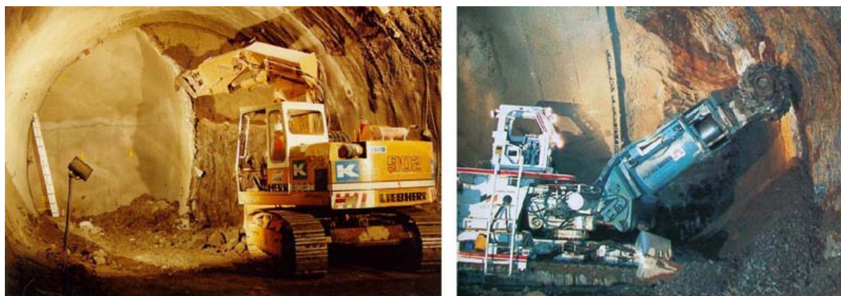
Figura 2a: Escavadeira em Túnel de Teste em Heathrow - London, UK 1994
