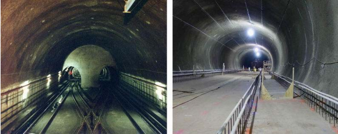
Figura 32a: Revestimento final em concreto projetado no túnel Hildarose no Metro de Washington WMATA - Wheaton, MD 1985
