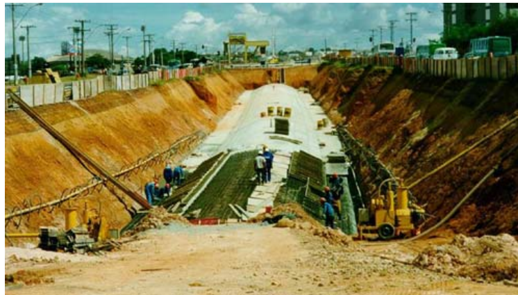
Figura 23: Instalação da Laje de Teto do Túnel Invertido no Metro de Brasília, Túnel Taguatinga, Brasil 1995
