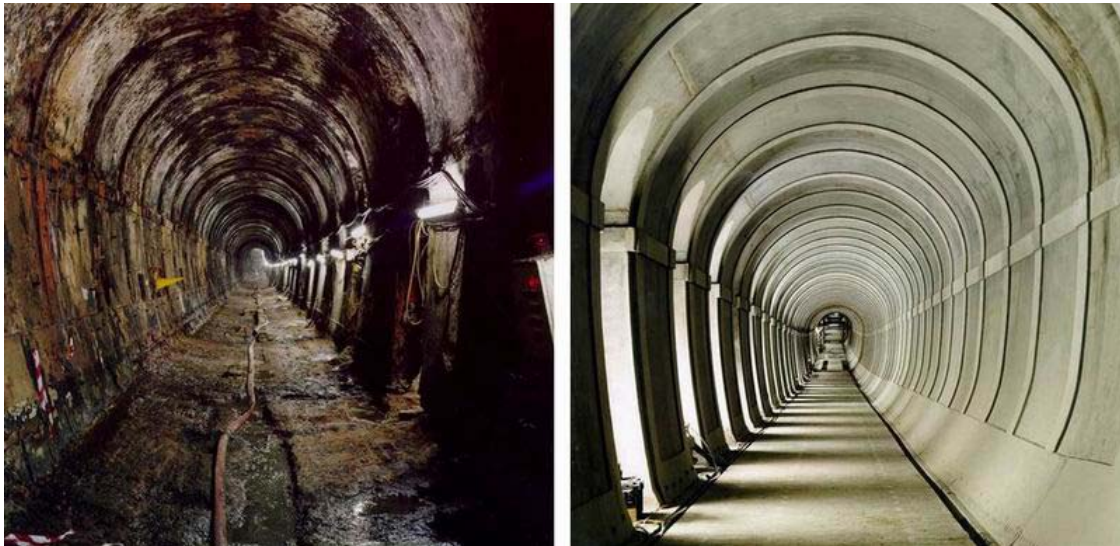
Figura 30a: Túnel de Brunel, construído sob o Rio Tamisa na década de 1830 - Londres, UK 1995
