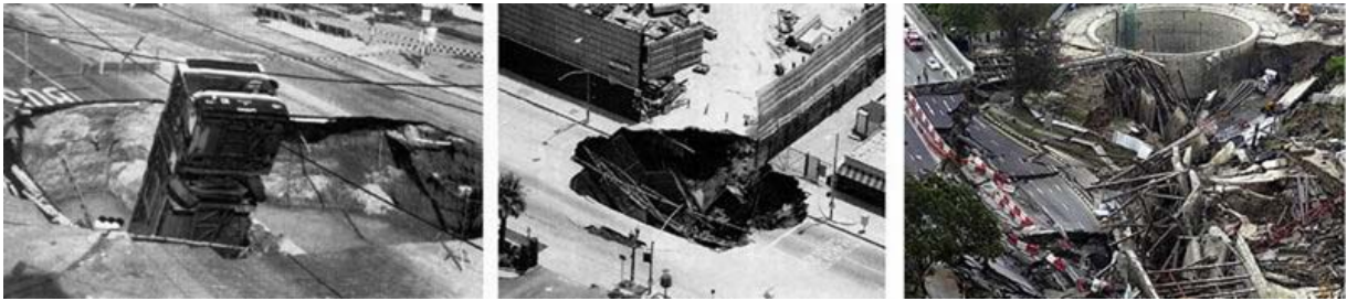
Figura 7a: Colapso de túnel NATM na Linha U-Bahn, Metrô de Munique, Alemanha 1994
