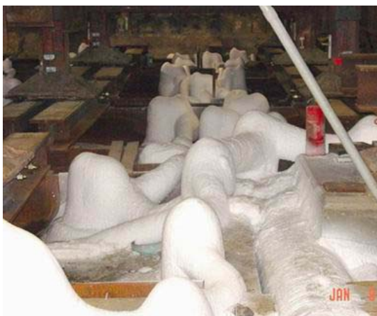
Figura 19a: Tubo de Congelamento Vertical, localizado no subsolo do Edifício “Cais da Rússia”, sobre o túnel MBTA – Boston, MA 2002
