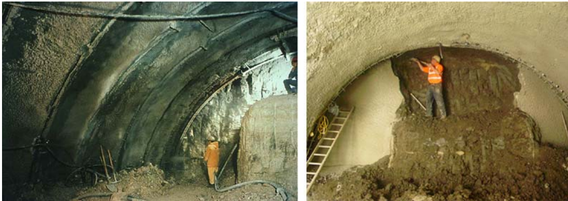
Figura 15a: Suporte da Face com Núcleo de Apoio, Metro de Paris, França, 1976
