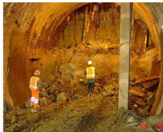
Figura 19a: Tubo de Congelamento Vertical, localizado no subsolo do Edifício “Cais da Rússia”, sobre o túnel MBTA – Boston, MA 2002
