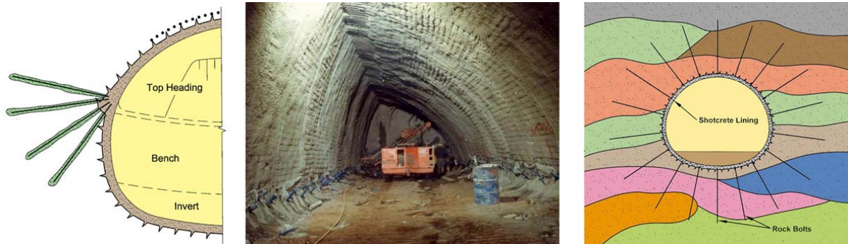
Figura 17a: Enfilagens Grouteadas na Sapata da Parede Lateral.
