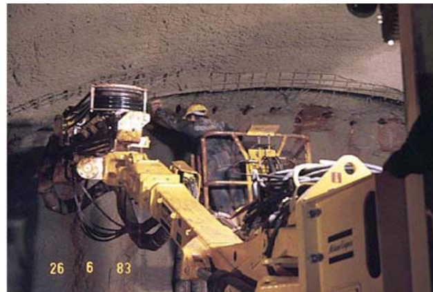
Figura 9a: Instalação de Enfilagens de Barra no Túnel Rupertus, Ferrovia OBB – Áustria, 1990
