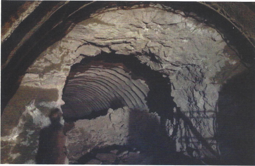
Figura 8 – Frente de encontro da escavação
