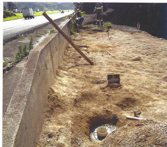
Figura 9 – Detalhe da instalação dos marcos superficiais
