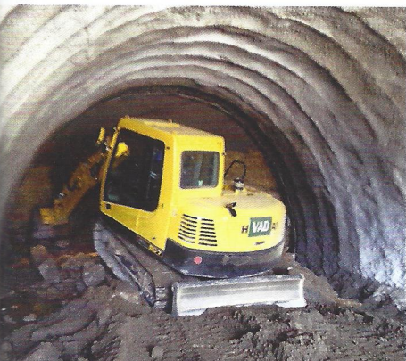
Figura 4 – Detalhe da escavação em saprólito, na frente de escavação sul
