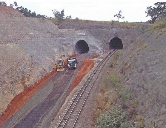
Figura 10 – Vista geral do Emboque Norte, após a conclusão das obras
