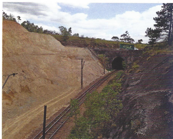
Figura 5 – Taludes no Emboque Norte, no início das escavações
