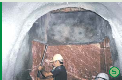
Túnel de ligação e escavação do poço retangular
