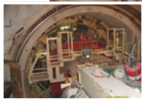
Foto 2 - Tuneladora em rocha para túnel sob a Serra do Mar
