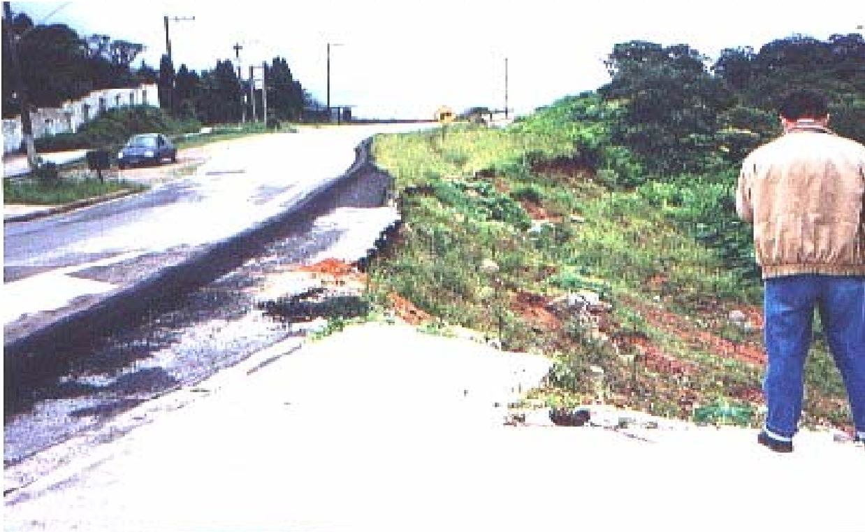
**Foto 1** – Falla o ruptura del terraplén
