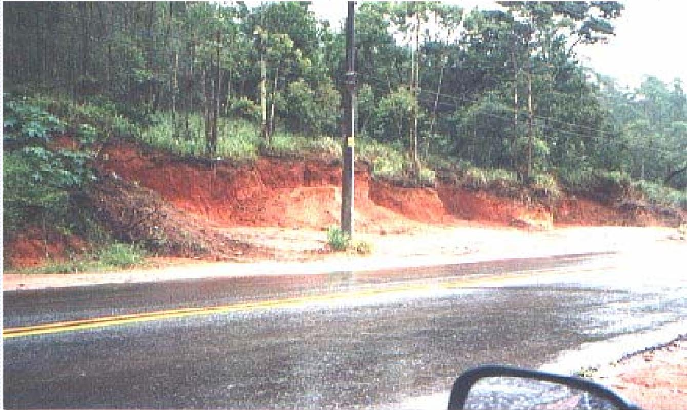
**Foto 3** - Banqueta de préstamo, con erosión y talud vertical
