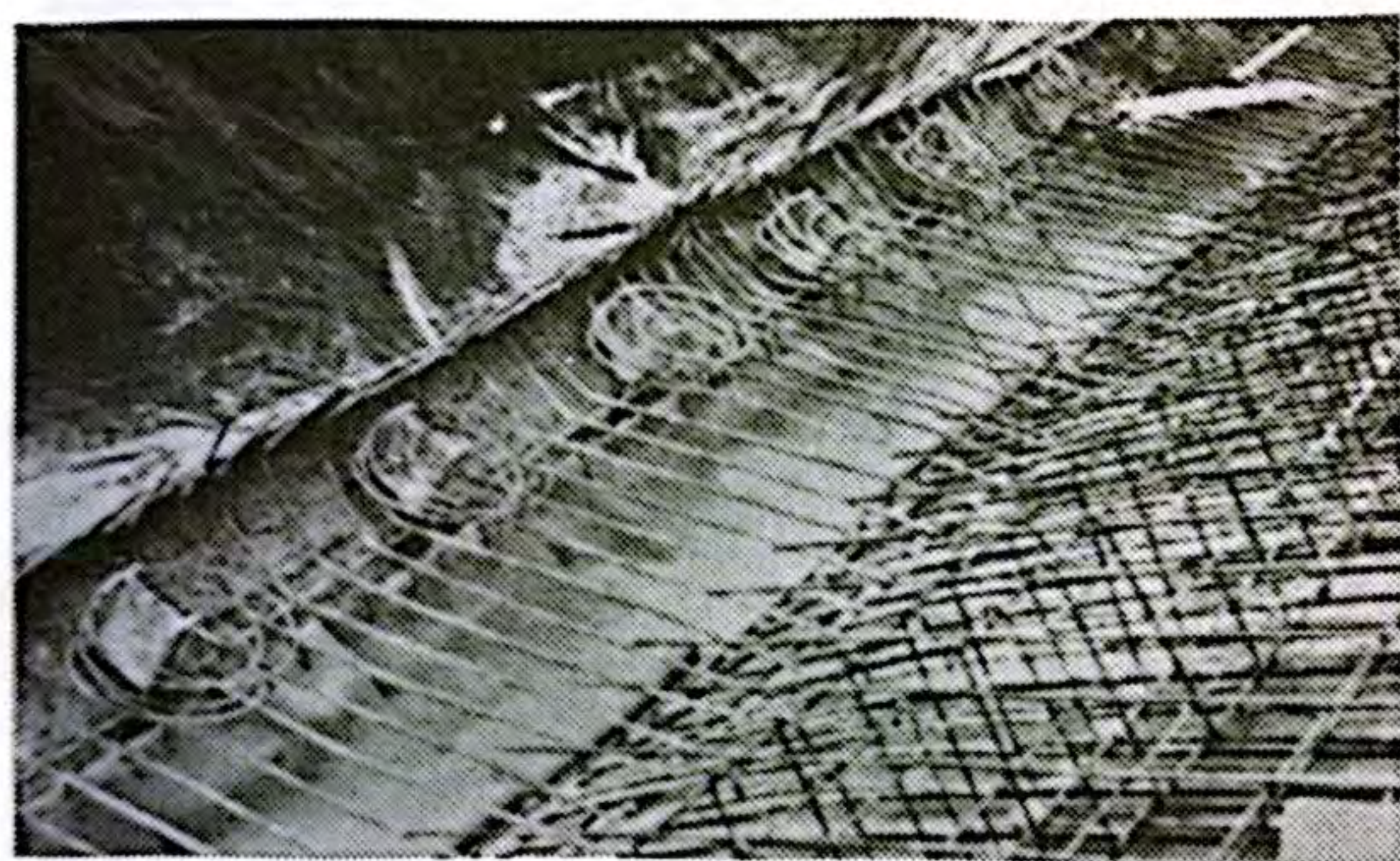
Figura 9. Detalhe da Armação na Cabeça da Estaca e Manta de Geocomposto.
