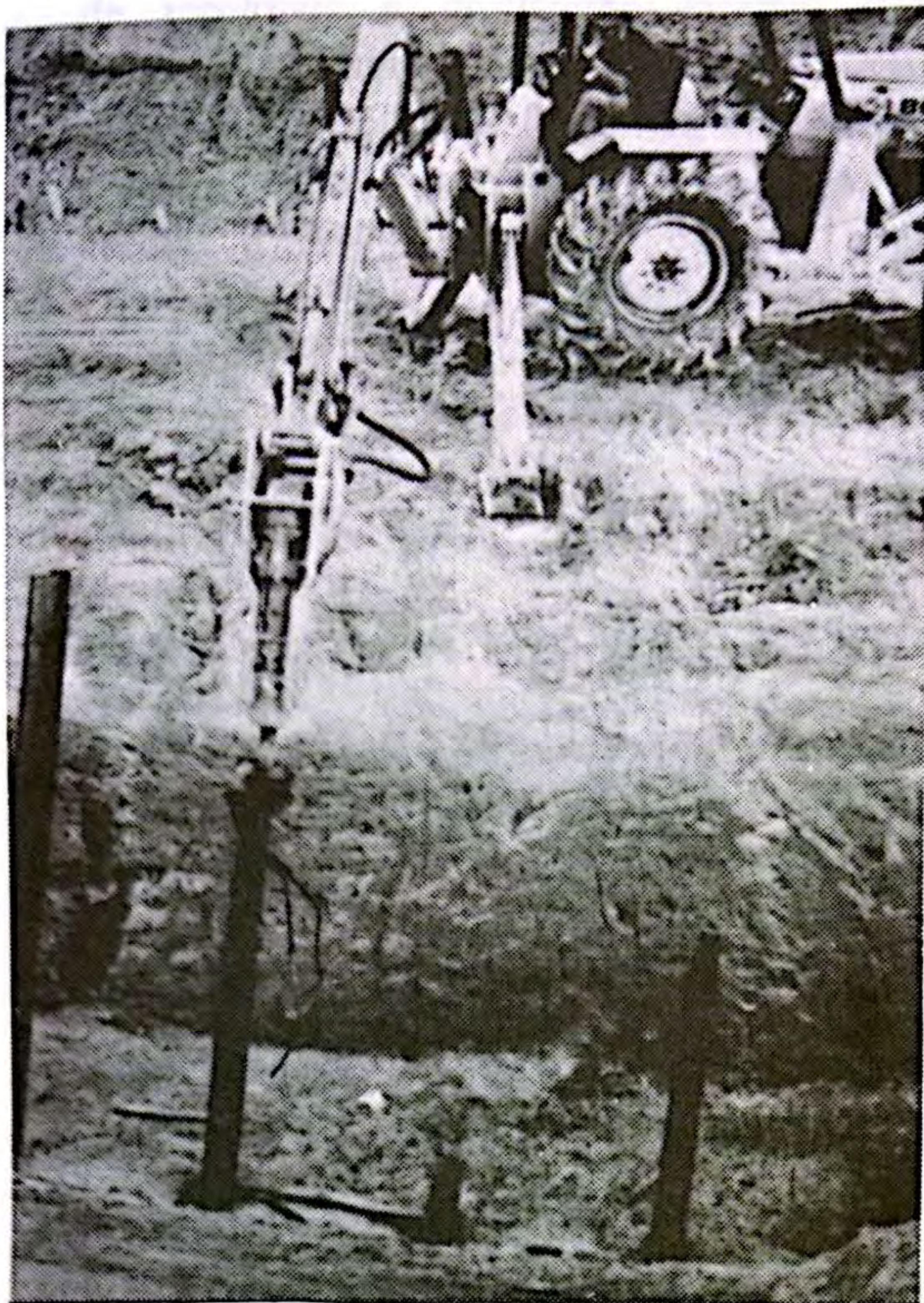
Figura 8. Detalhe da Retro-Escavadeira Adaptada para a Cravação dos Perfis Metálicos.
