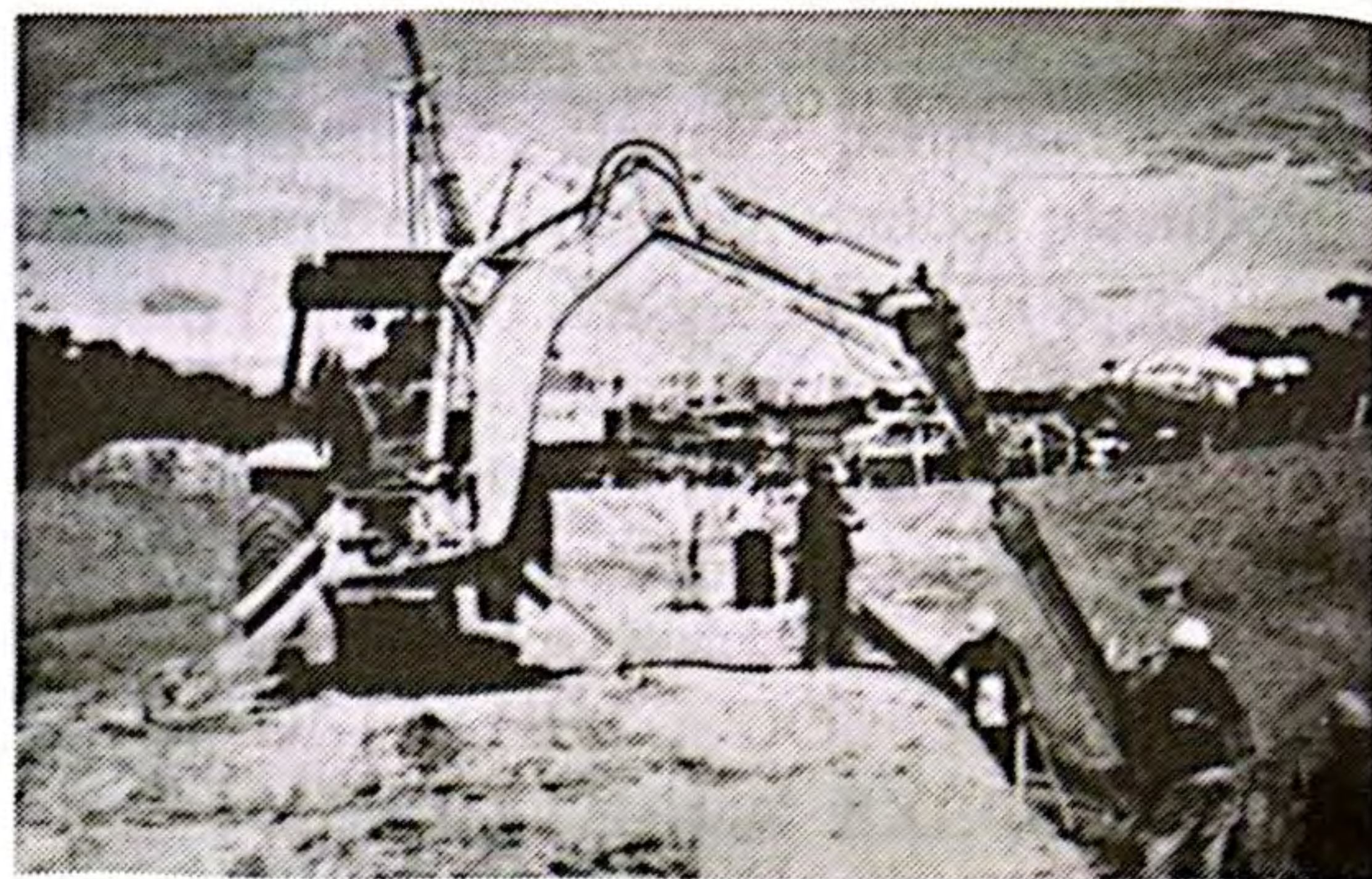
Figura 10. Vista da Operação de Cravação
